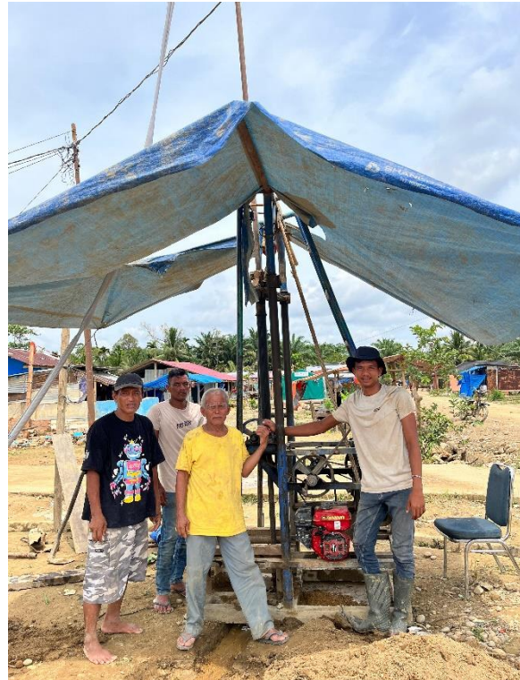
Proses pemasangan sumur bor/telaga tiup di pemukimah perkemahan dan kawasan terisolasi
